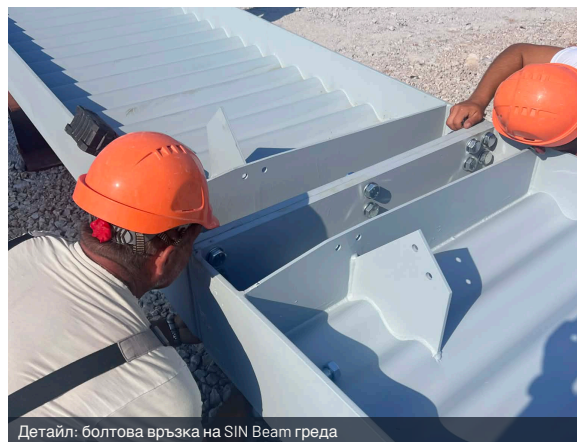
Детайл: болтова връзка на SIN Veam греда
